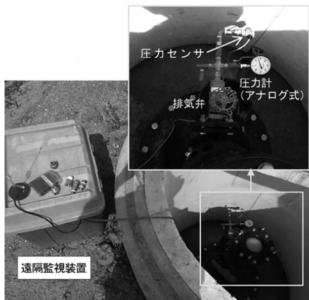
写真-1 遠隔監視装置設置状況
