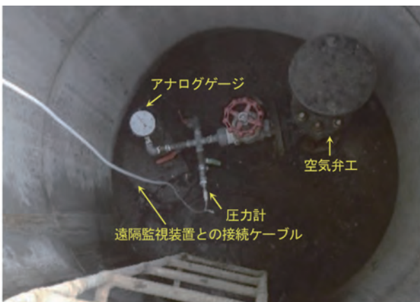
写真－6 管内圧力計設置状況（空気弁工）
