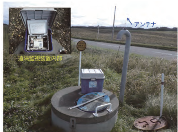
写真－7 遠隔監視装置設置状況
